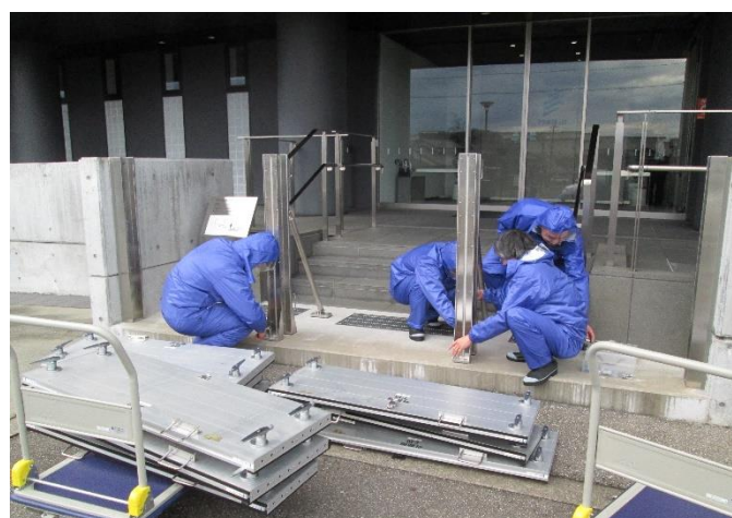
正面玄関には支柱を設置後、止水板を設置
