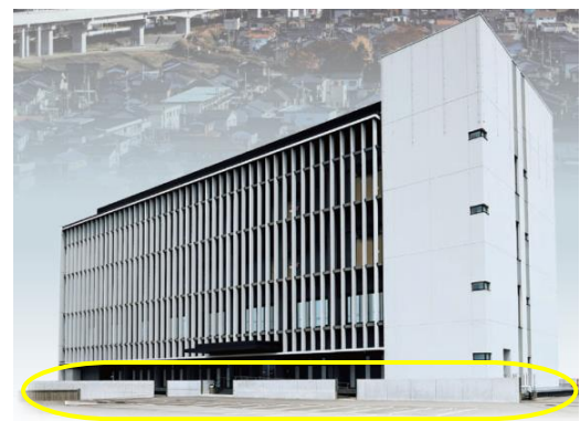
通常、止水板は設置しておりません
