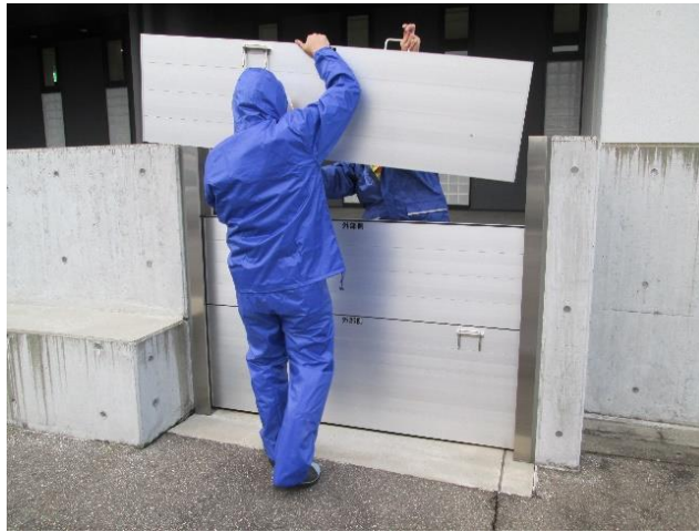
止水板設置箇所は6箇所あるため、分かれて一斉に作業実施
